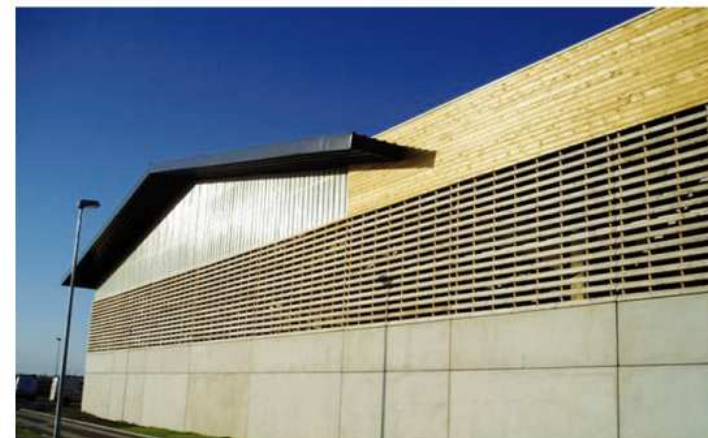
Bardage bois et métallique - Sevadec à Calais
