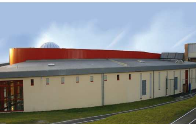
Étanchéité membrane PVC - Collège Gaspard Malo à Dunkerque
