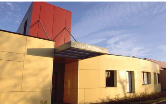
Étanchéité multi-couche et bardage - Maison de la petite enfance à Marck
