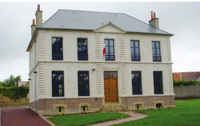
Couverture ardoise - Hôtel de Ville de Camblineul
