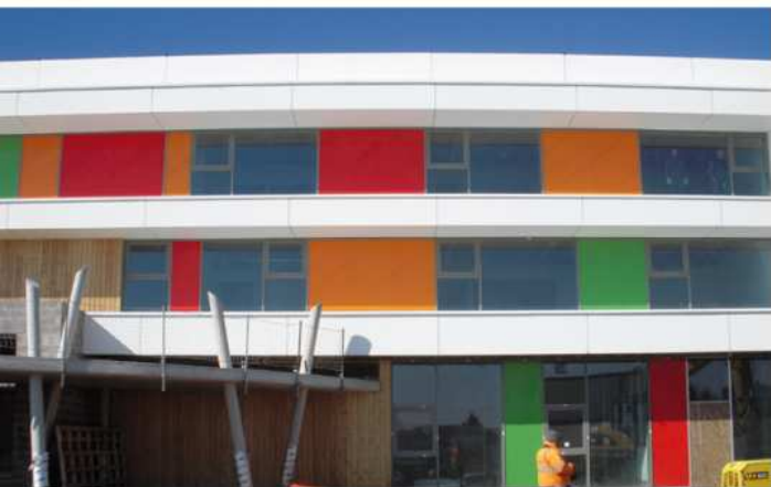
Isolation par l'extérieur et bardage - Hôtel Communautaire de Marquise
