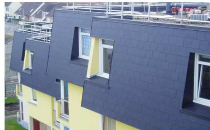
Ardoise et étanchéité multi-couches - Résidence Pascal à Marck-en-Calais
