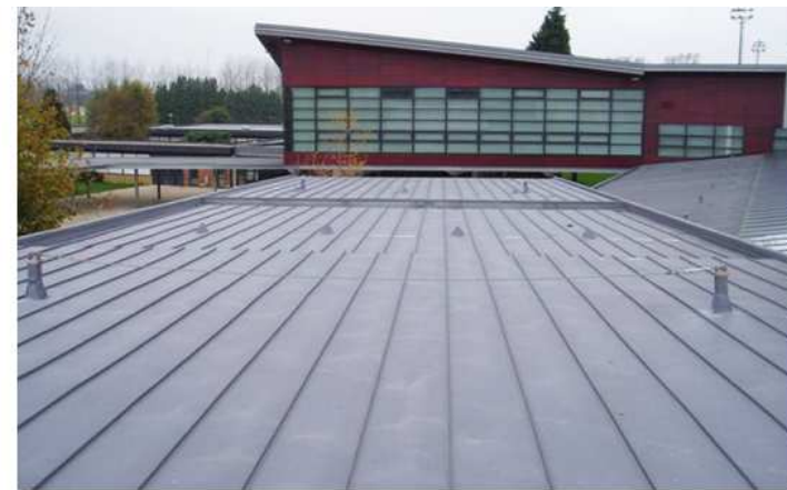
Toiture en zinc - Collège de Bredenaerde à Audruicq
