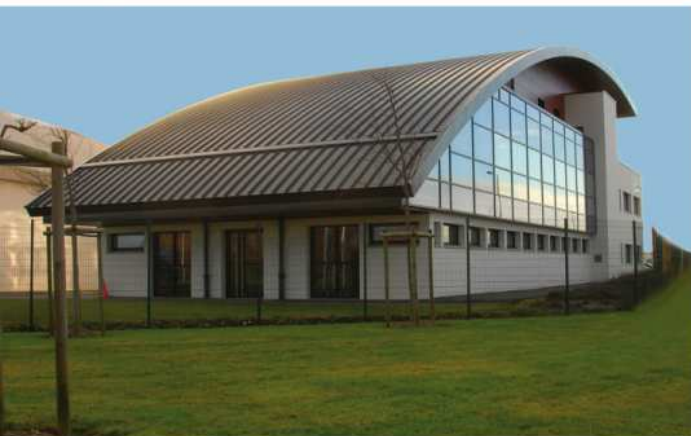
Couverture alu à joint debout - Bâtiment administratif du dépôt de bus à Calais
