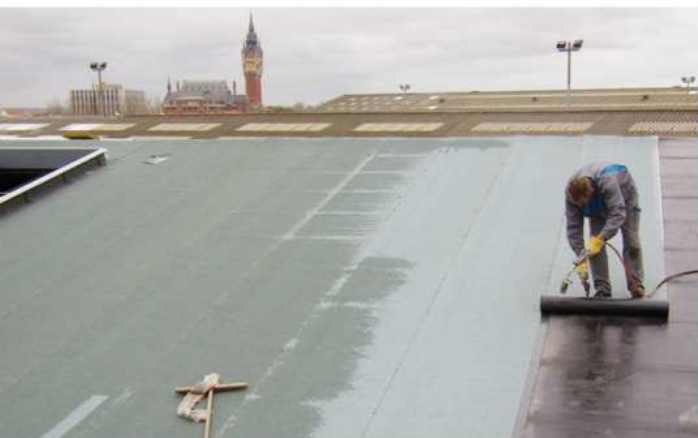
Etanchéité - Bâtiment de stockage de la CCI de Calais
